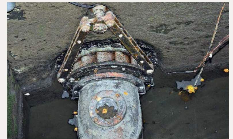
Pou a cel obert amb la turbina Francis i el sistema de comandament de les pales del distribuïdor.
