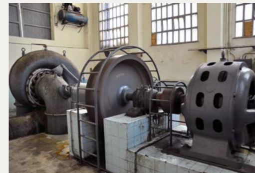
El grup compost per la turbina Benito Martínez i el generador síncron LESA.
