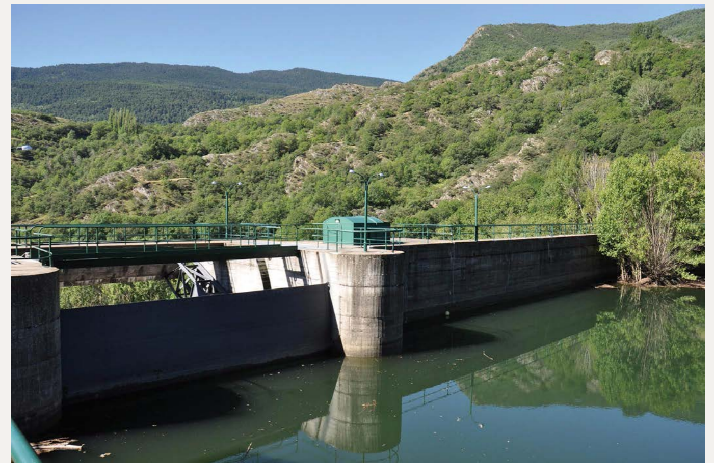
Presa de Borén vista des de l'embassament i detall de la comporta.
