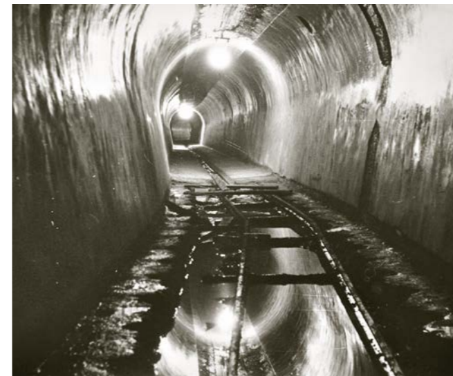
La galeria d'Arties acabada de construir. (AAM)
