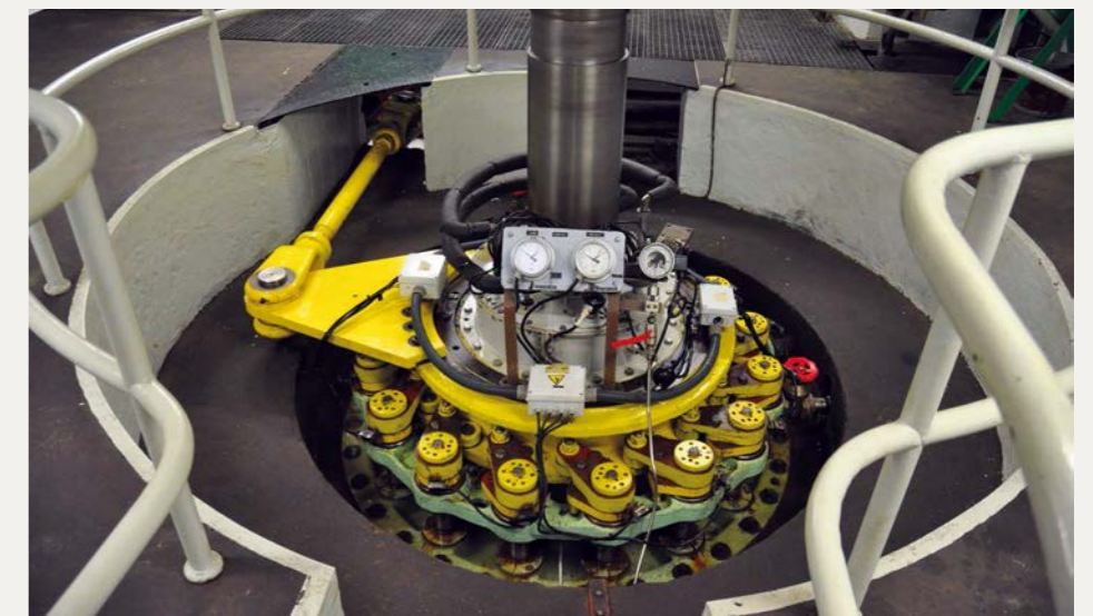
Comandament de la turbina d'un dels dos grups de Benós.
