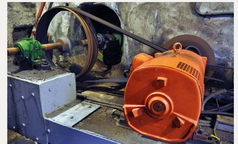
Maquinària de la central. A l'esquerra, la turbina Francis; a la dreta, el nou generador síncron.
