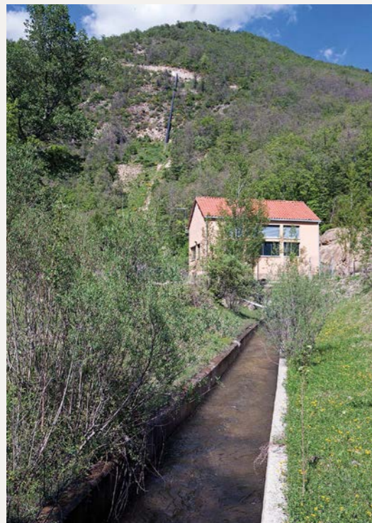
La canonada i l'edifici de la central del Serradó. A primer terme, el canal de desguàs.
