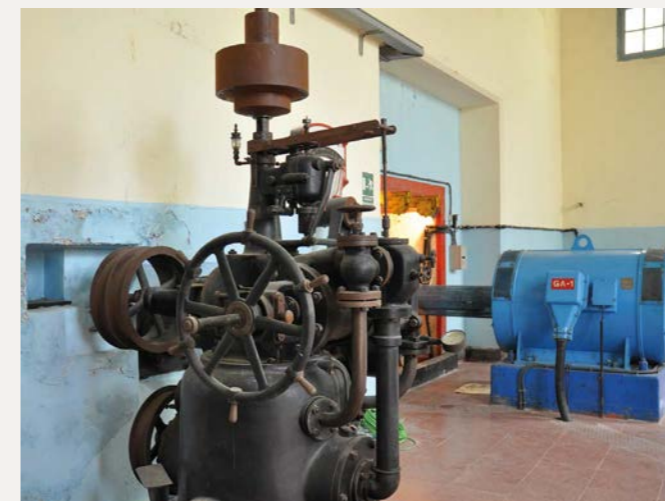
Antic regulador de velocitat i el motor Siemens al fons.
