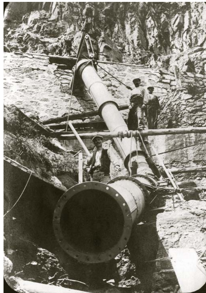
Cambra d'aigües superior. Instal·lació de la canonada forçada a la central Freser Superior, any 1902-1903. (Hidrodata)
