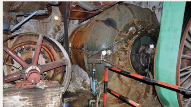
Les dues turbines de cambra tancada i eix horitzontal.
