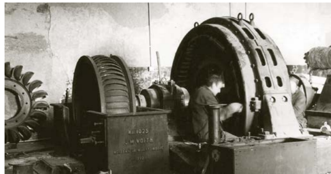
Turbina Voith núm. 1025, la primera que es va instal·lar l'any 1902, desmuntada, i operaris treballant a l'alternador núm. 1. A la paret s'observa un rodet Pelton. Any 1998. (Hidrodata)
