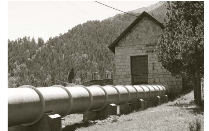
La canonada forçada de la central de Sant Maurici a la sortida de la cambra d'aigües. (AAM)
