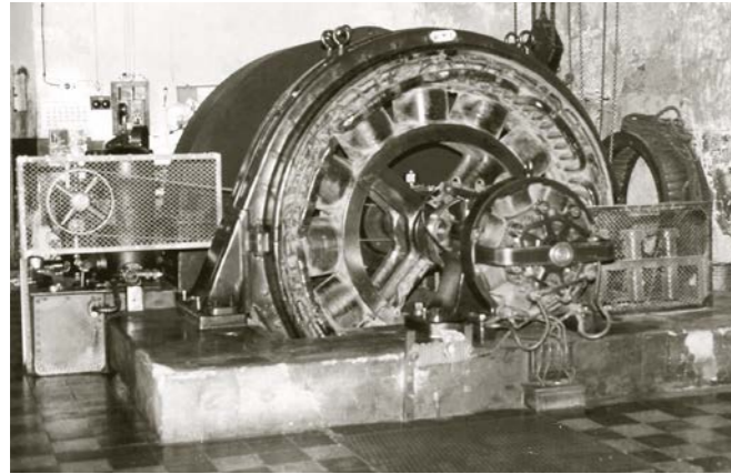
Alternador 1 de la central Freser Superior. A la dreta s'observa un rodet igual al que tenia la turbina. (Hidrodata)
