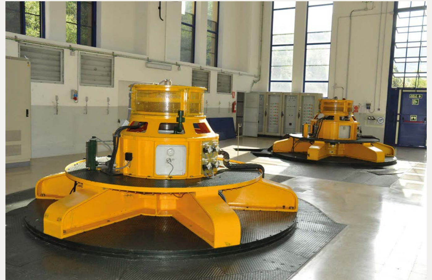
Sala de màquines amb els dos grups de Benós.
