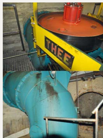
Dins de la canonada es troba la turbina semi-Kaplan vertical.
