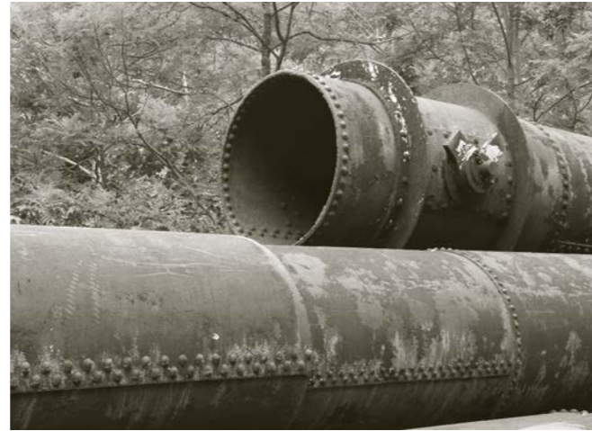
Les canonades reblades utilitzades els anys 1900 per tot el conjunt del Freser. (AAM)
