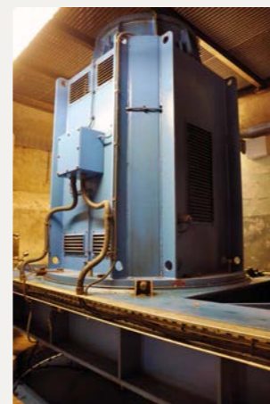
Generador síncron de la turbina Kaplan.
