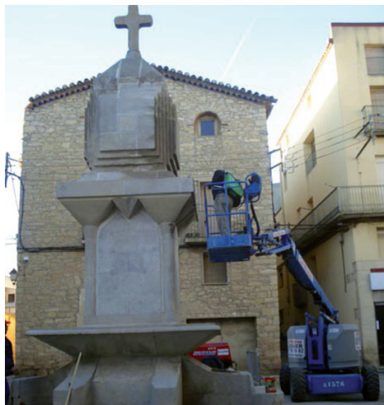
Obres de condicionament del monument el 20 de desembre de 2010.
